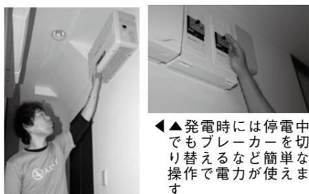
▲発電時には停電中でもブレーカーを切り替えるなど簡単な操作で電力が使えます
