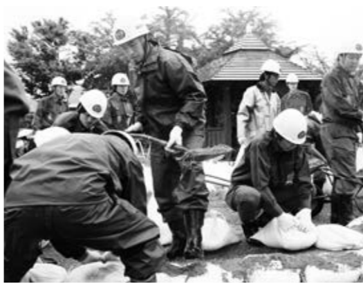
▲積土の工法を行う消防団員たち
