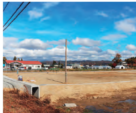
▲造成工事中の商業・医療エリア
