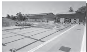
▲改修した大塚小学校のプール
