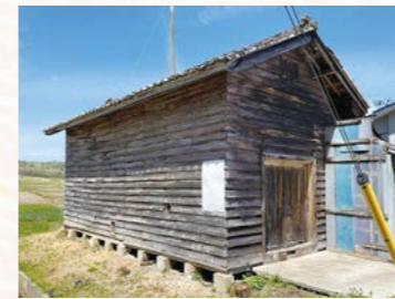
▲個人宅の倉庫として活用されている恩賜郷倉(町内)
