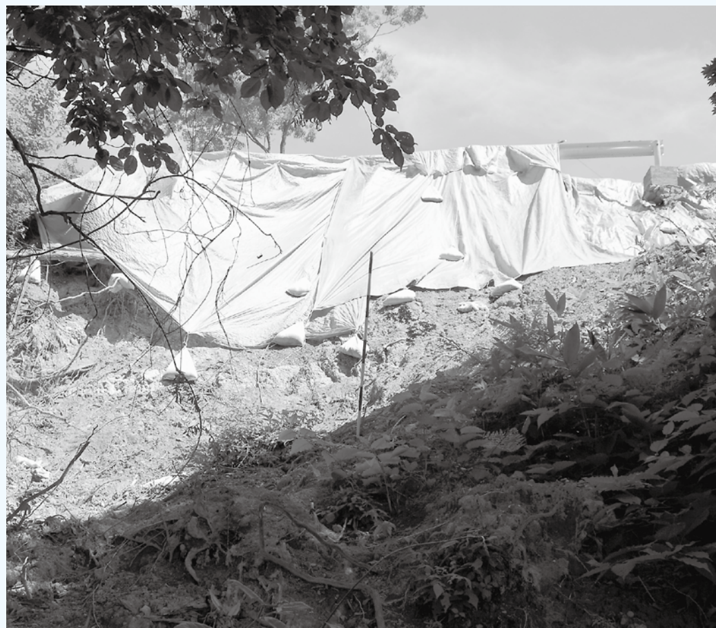
復旧急ぐ崩落現場・置賜公園北側
