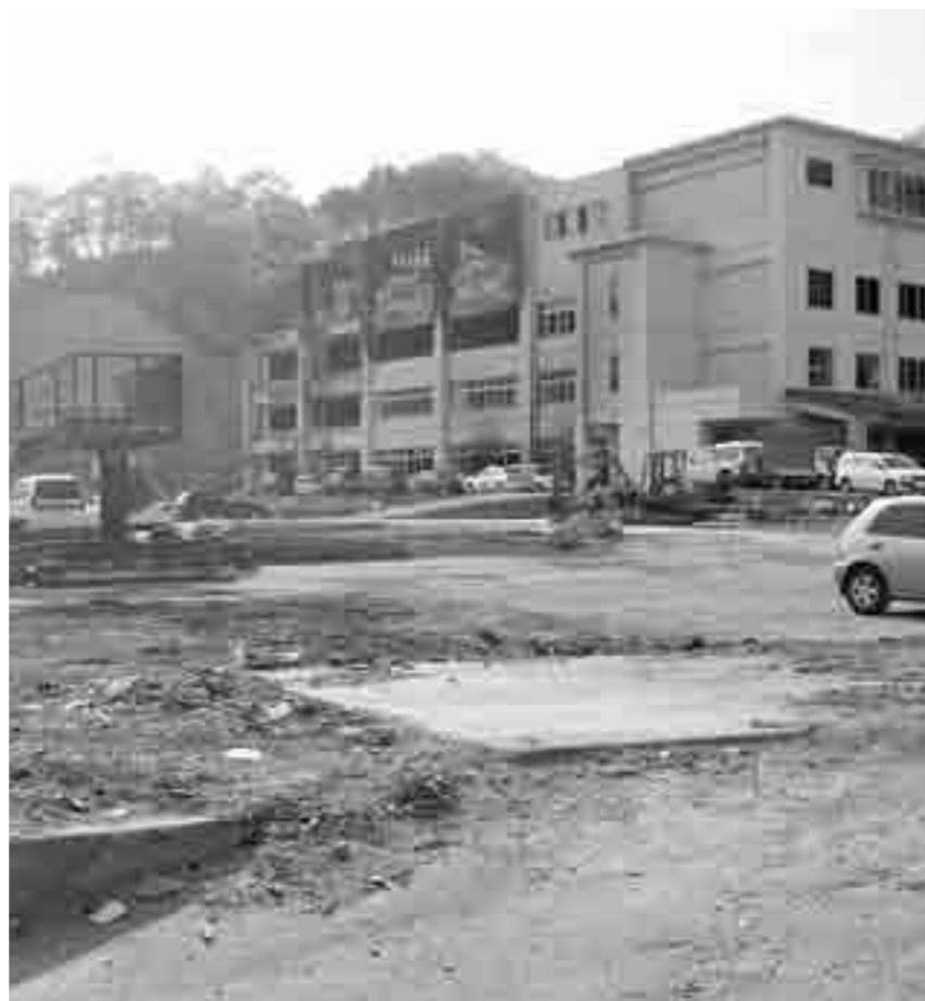
被災した大槌町役場
