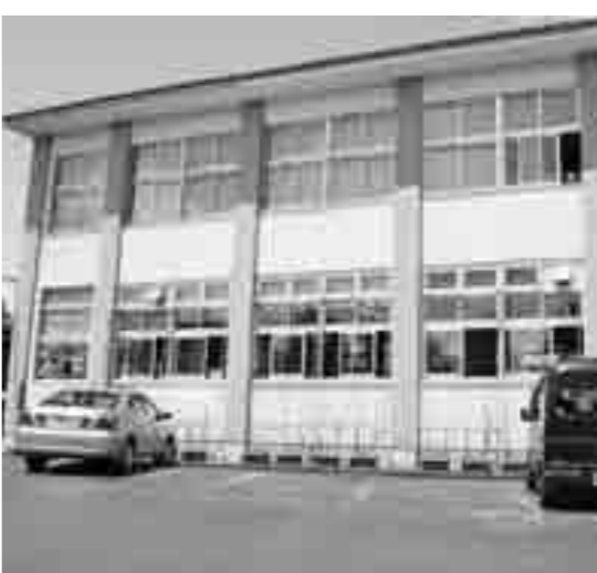
町庁舎南側に植え付けられたグリーンカーテン（あさがお）
