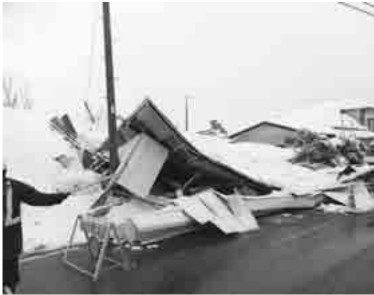
地震により倒壊した町内の車庫
