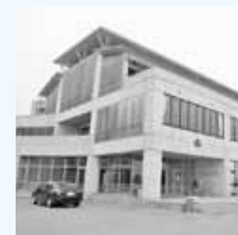
屋根改修工事を行なう旧2中校舎
