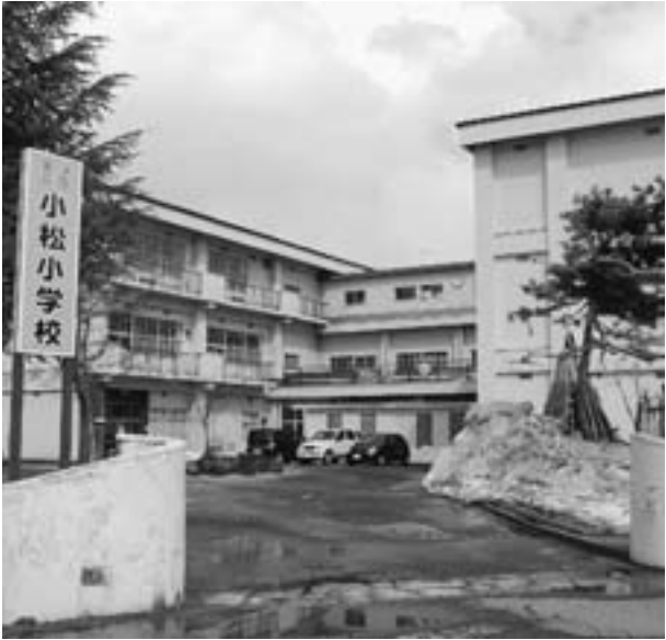
全面改築となる小松小学校、工事は24年度から
