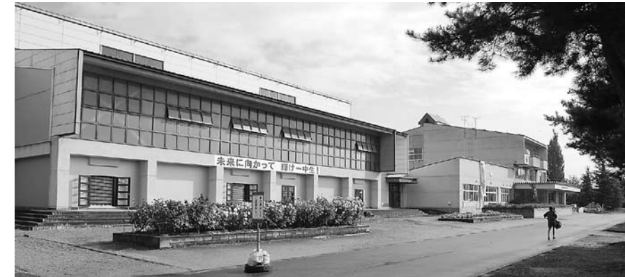
新中学校となる川西第一中学校
