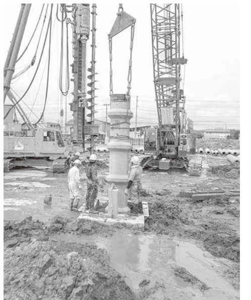
新庁舎の基礎杭打設工事が進む
