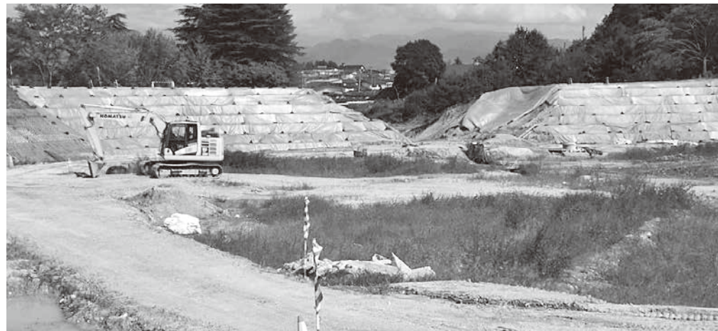
鏡沼改良復旧工事、順調に進む
