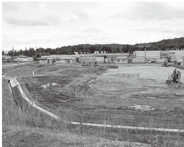
三菱鉛筆新規工場用地造成が進んでいる = 二井町地内
