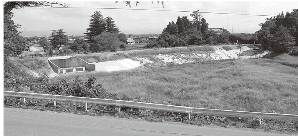
鏡沼工事は「湛水試験」などを経て完了へ
