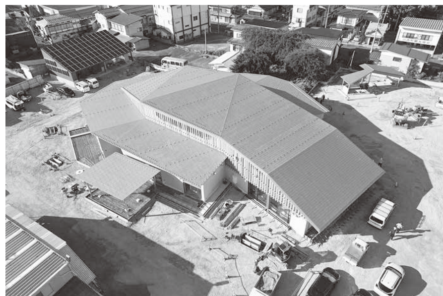
完成間近のまちなかテラス
