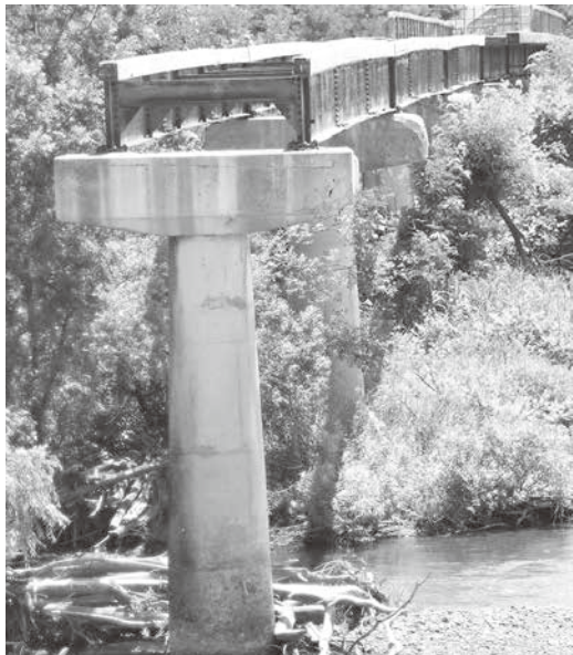
旧道坂水橋橋梁撤去工事
