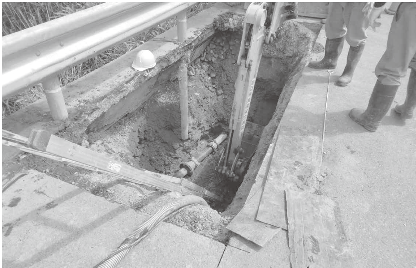
水道管漏水も多発＝老朽管交換工事
