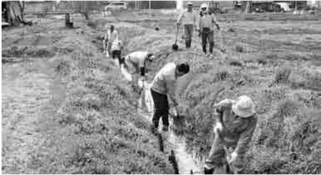
向上活動を支援する農地・水環境保全事業、今後はコンクリート水路整備もできる
