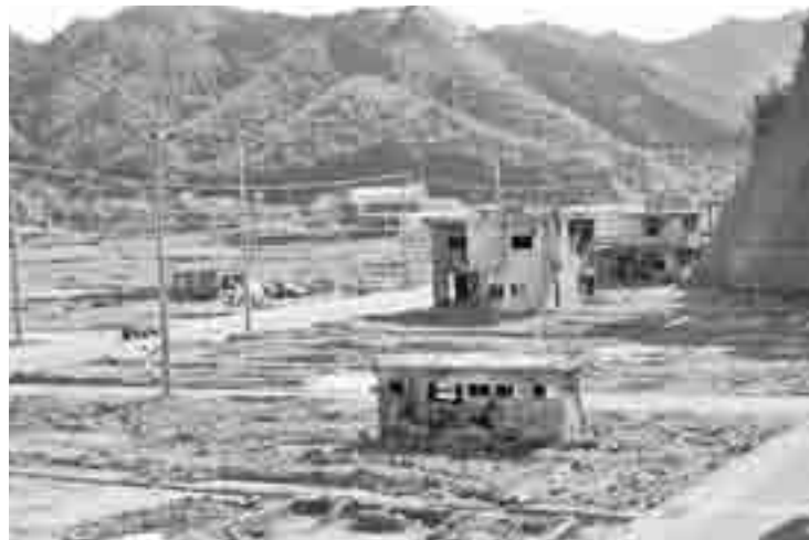
壊滅的な被害を受けた大槌町の中心部
