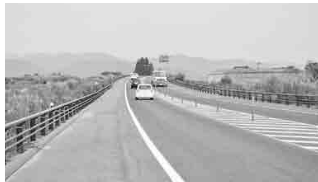
完成した国道113号線梨郷道路（宮内地内）日本海国土軸の整備が求められる
