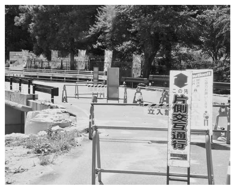
町道上六角平谷地線(ダリヤ園)復旧工事
